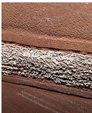
Abb. 9: Messerlinienkorrosion an einer Auskleidung in einem Harnstoffreaktor (Brouwer, 2023)
